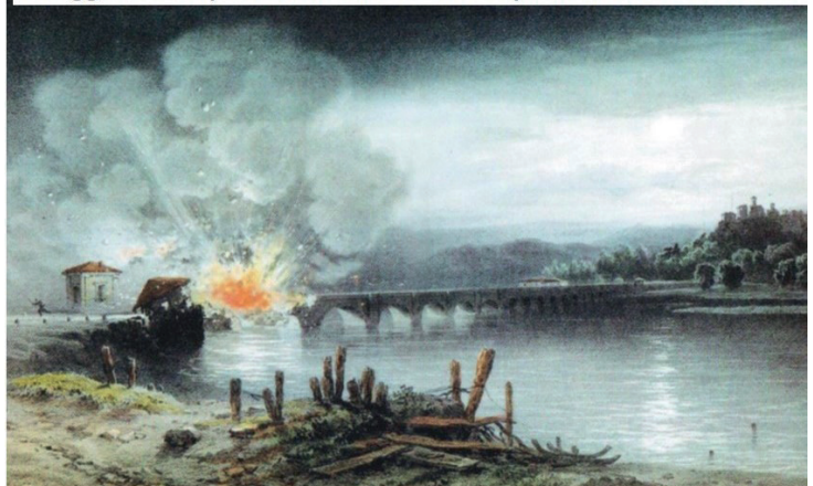
4 maggio 1859: Il ponte della ferrovia con l'esplosione delle due arcate.
